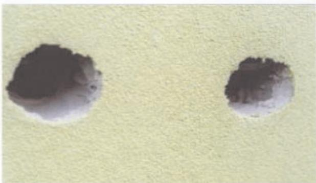
Otwory do stropodachów (przedłużone o 10 cm grubość styropianu) po obróbce wewnętrznej i po nałożeniu tynku, a następnie farby na elewację. Tak starannie wykonane otwory powinny gwarantować bezpieczeństwo ptakom.
